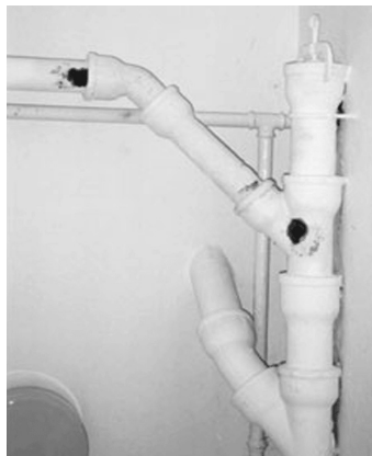
圖 20、冷凝水造成管壁鏽蝕與長黴
