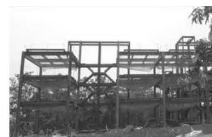
持戒、修定，必依「正見」；猶如造屋，先建棟梁。 （香光山工地，Jinyin 攝）
