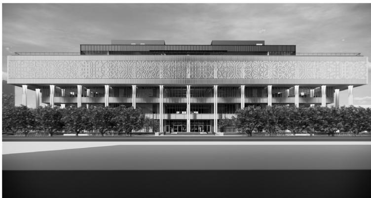
圖3：新總館外觀示意圖——出簷設計，由下而上逐層向外出挑，減少直接日照。最上層立面格柵，除了阻熱功能，也避免陽光直射。
